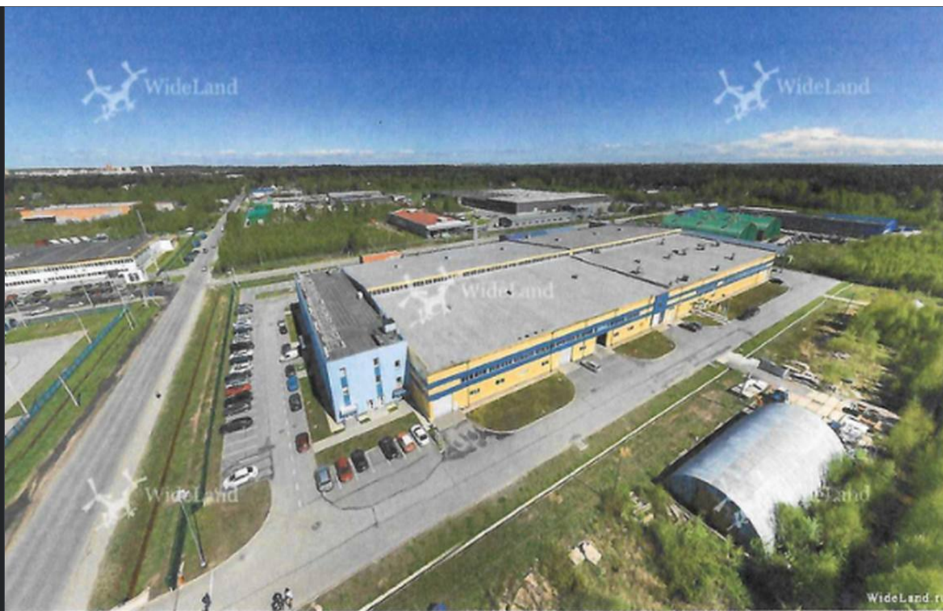
Комплекс с высоты: АБК, производственные корпуса, тёплый склад
